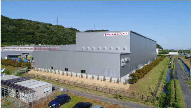
(上石津工場敷地内 新プレス工場外観)
