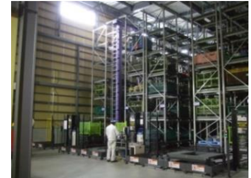
全拠点で稼働したスマート倉庫(自動倉庫)
