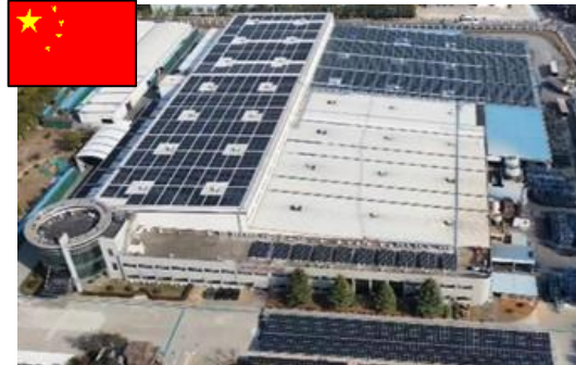
武漢丸順 太陽光パネル
