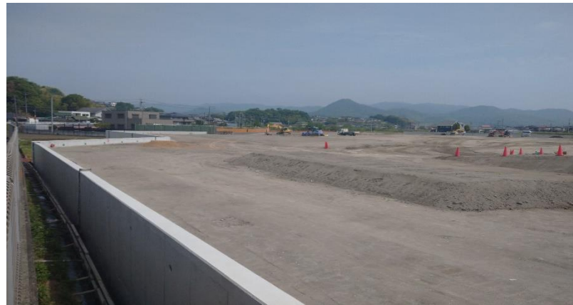
岡山工場 建設状況（造成中）
