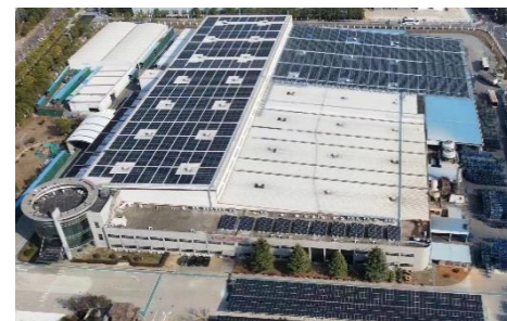
武漢丸順 太陽光パネル
