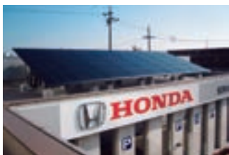
ホンダカーズ大垣新田店に設置の 太陽光発電パネル
