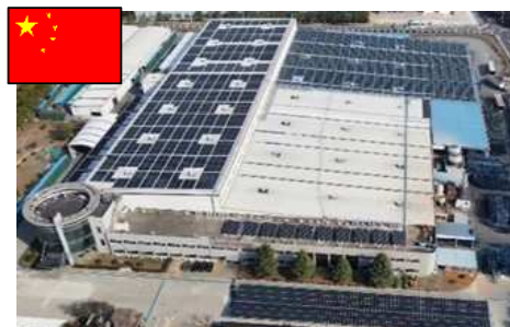
武漢丸順 太陽光パネル
