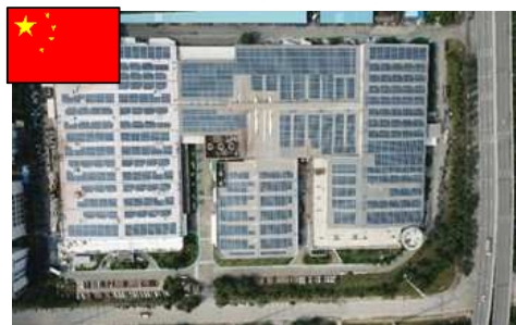
広州丸順 太陽光パネル
