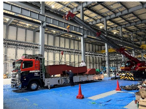
天井クレーンおよびコンベア据付
